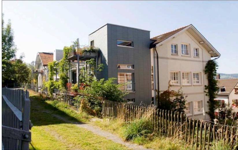
Altershausgemeinschaft Soliensieme, St.Gallen - alt und neu kombiniert
